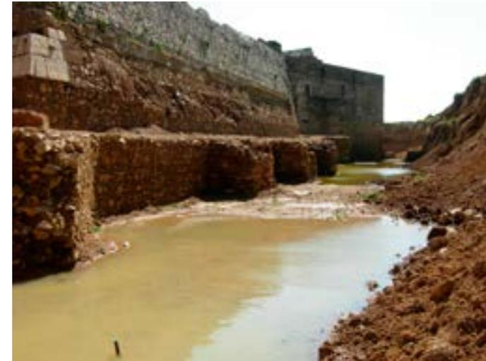
Nº 25.- Galería de contramina con sus ramales de salida en la cara oeste del caballero, desplomada en su coronación hacia el interior (2010). (J.M. Vázquez).
