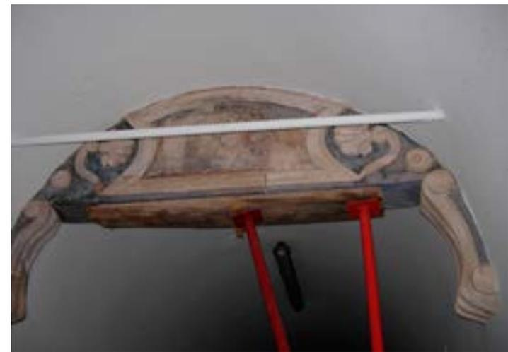
Nº 32.- Grieta en el arco de una de las capillas laterales tras la operación de vaciado. Atirantado de la bóveda. (J.M. Vázquez).
